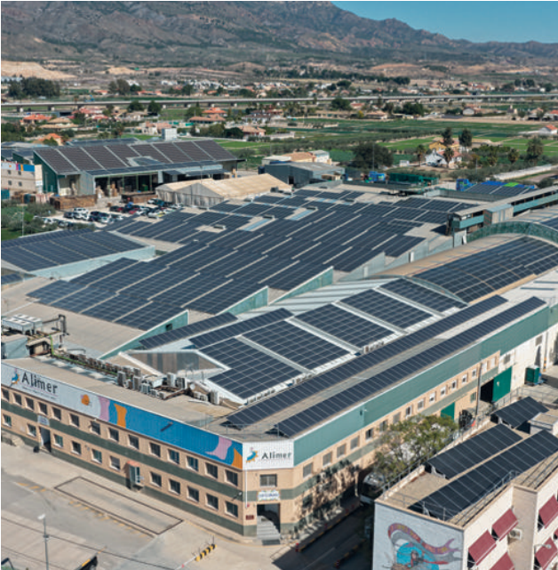
Imagen planta fotovoltaica centro hortofrutícola Lorca 001.
